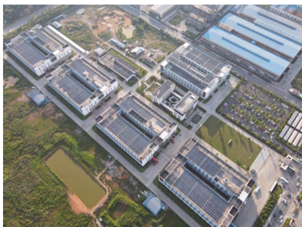
Figure 2.11. Dispositifs de production d'énergie photovoltaïque en toiture de l'usine de la base de Jiangshan du groupe Zhejiang Jiansheng.
