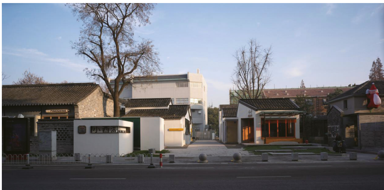
Figure 5.8. Un passage après rénovation.
