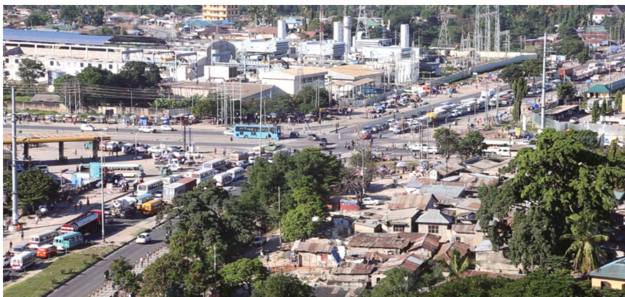
Figure 7.12. Le carrefour d'Ubungo avant sa rénovation. Source: China Civil Engineering Construction Corporation
